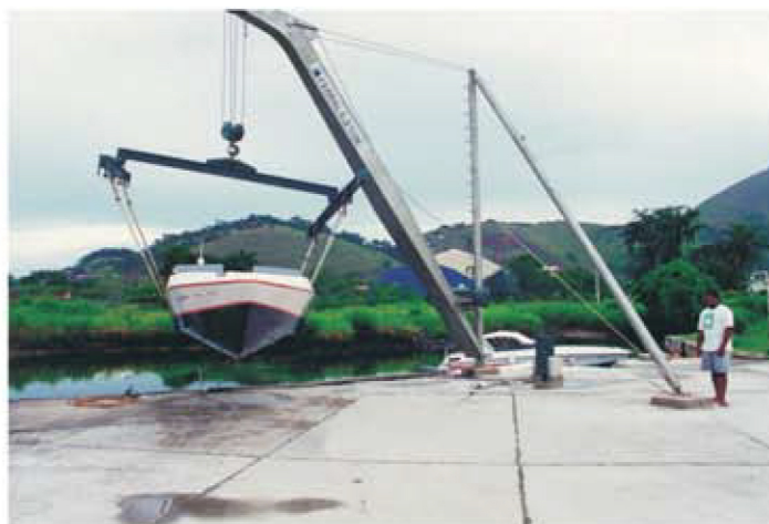
Derrick Cap. 6,3 ton - Marina Porto Frade
