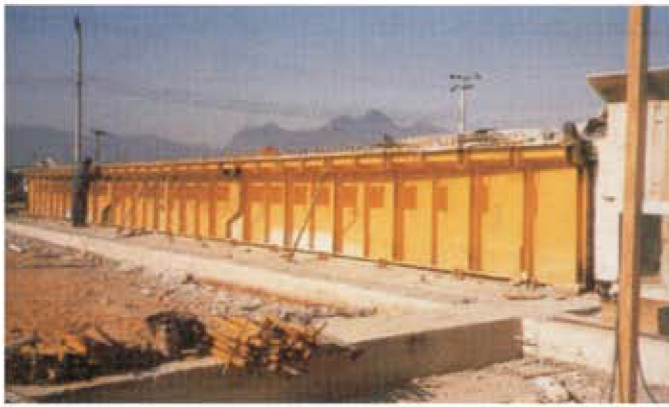
Obra: Linha Vermelha - RJ Construtora Carioca Engenharia
