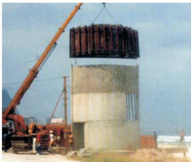
Obra: Rio Orla - RJ Construtora FERCON
