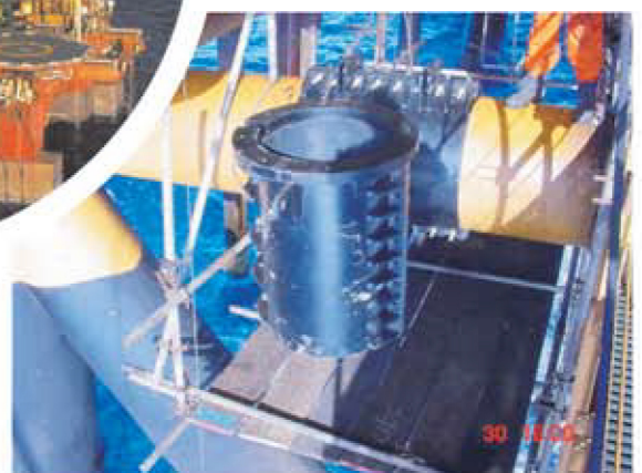
Braçadeiras Metálicas para fixação de Riser da plataforma de Garoupa
