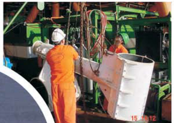
Braçadeiras Metálicas para fixação de Riser da plataforma de Garoupa
