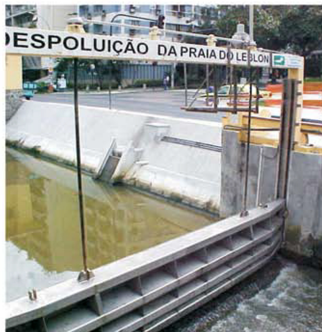
Comporta deslizante com acionamento dupla aste através de atuador eletro-mecânico
