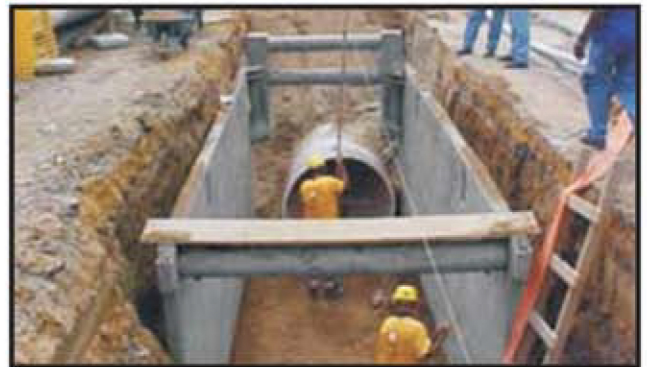
Assentamento de galeria.
